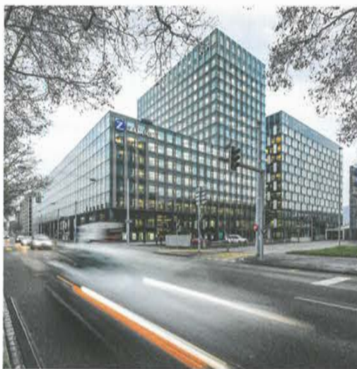
Skykey an der Hagenholzstrasse in Zürich ist eine Bürostadt im Haus: 2500 Arbeitsplätze finden auf 40 000 Quadratmetern Platz.
