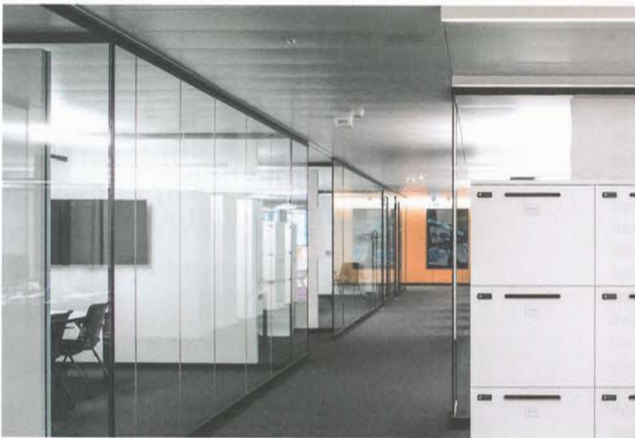
Ohne Schrauben und Decken- oder Bodenschoner: Die Stellwände im Bürohaus Skykey werden einfach in die schwarzen Schienen geschoben.
