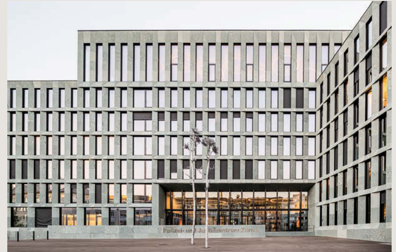
Eine einheitliche Natursteinfassade umhüllt die diversen Nutzungen. • A uniform natural stone façade
