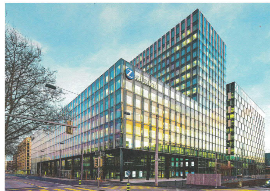
Bürohaus SkyKey (Architekt: Theo Hotz AG, 2011–2014) und rechts Business Center Andreasark (Architekt: Steiner AG, 2008–2011).
