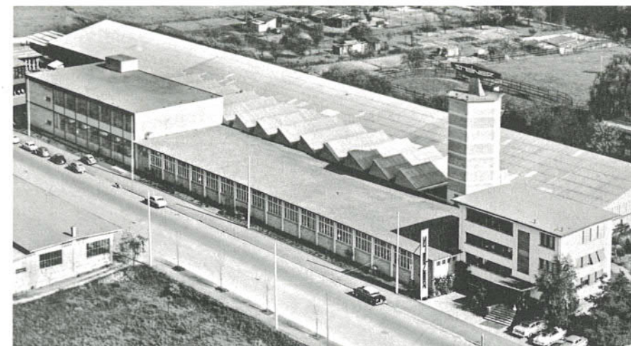
Das Steiner-Stammareal 1950 mit der Halle für Holzverarbeitung, Werkstätten und dem Bürohaus der Schreinerei Karl Steiner.
