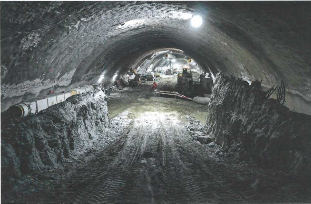
Die Kaverne Nord ist zur Hälfte ausgebrochen. Links und rechts die Reste der Paramentwände zwischen den Sektoren der Ausbruchetappen 2 und 4. Foto: Martin Schäfer
